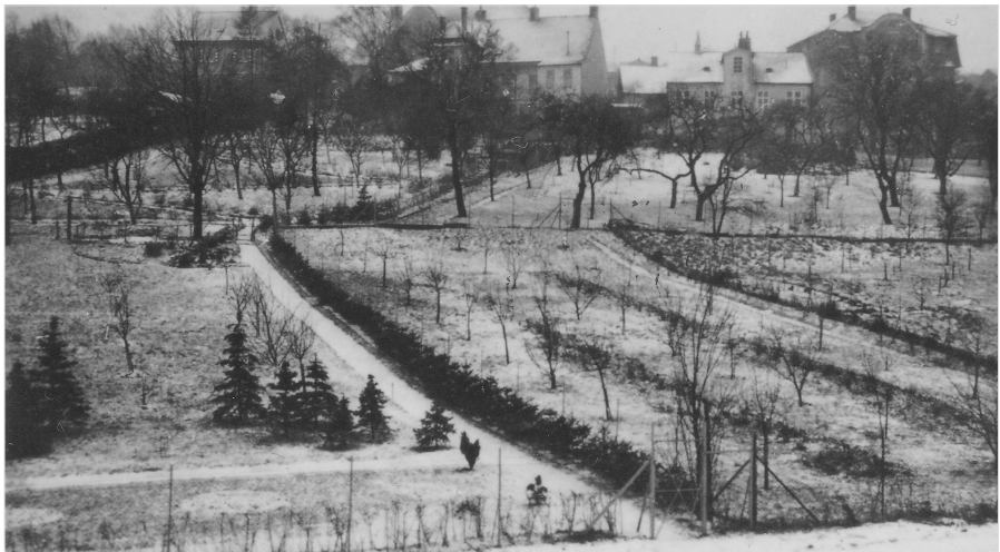
Unverbaute rechte Krottenbachseite im Bereich Rathstraße 13 und 15
